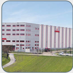
Helukabel Logistikzentrum in Betrieb genommen S. 2
